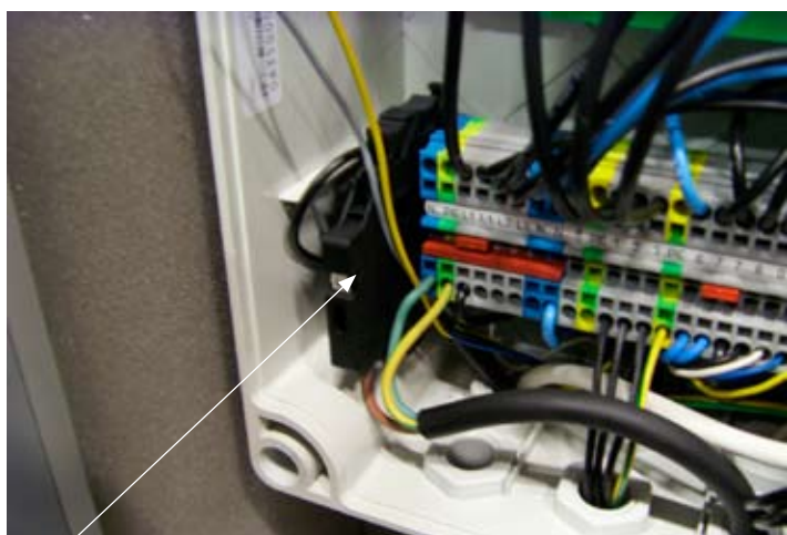
Tryck ner säkringshållare i L-plint.
