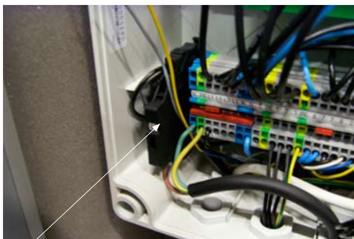
Poussez le porte-fusible dans le bloc de raccordement L.
