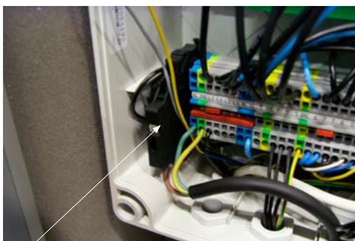
Tryck ner säkringshållare i L-plint.
