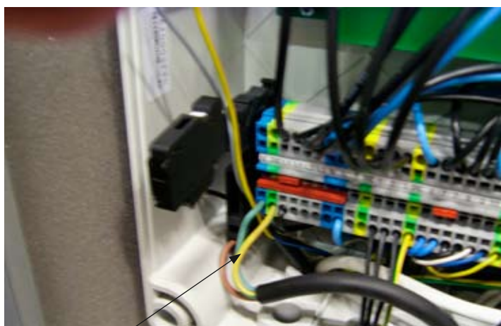
Montera N och PE i plint.
