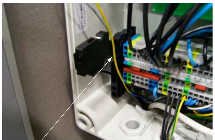
Sicherungshalter vom L-sockel anheben.
