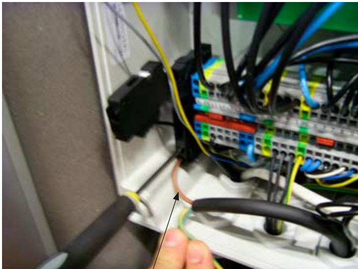
Phase im l-sockel montiert.
