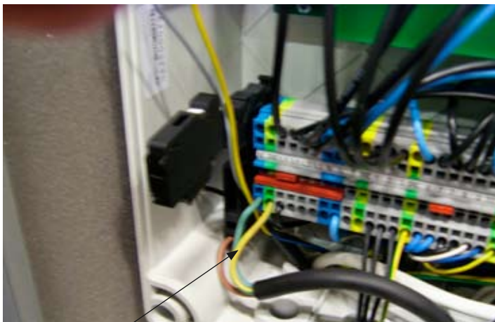
N und PE im Sockel montieren
