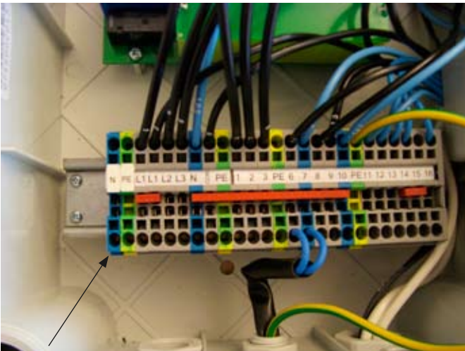
Die N-Leiter-Reihenklamme wie abgebildet befestigen.
