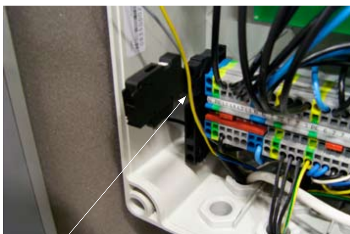
Lyft upp säkringshållare i L-plint.
