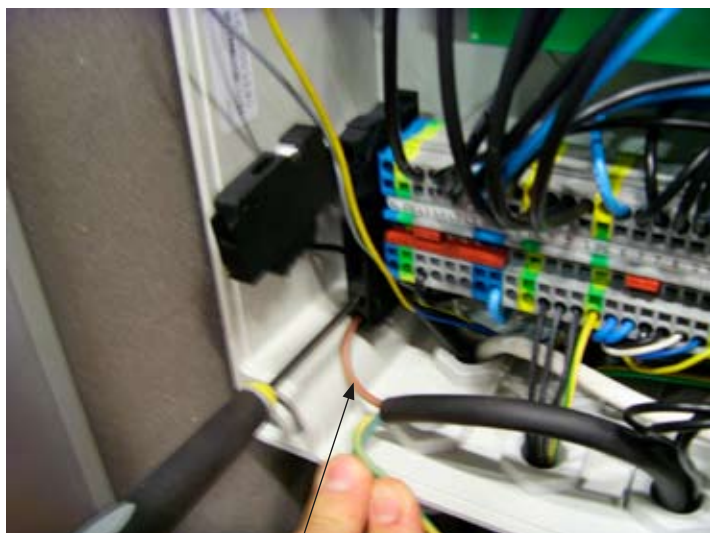
Montez la phase dans le bloc de raccordement L.
