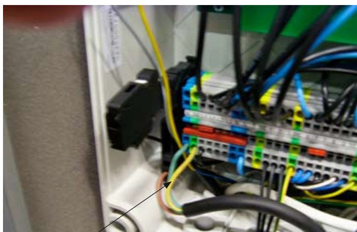
Montez N et Pe dans le bloc de raccordement.
