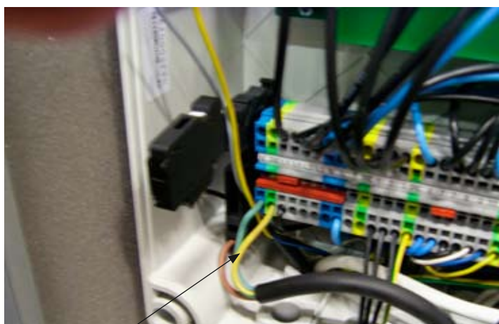
Montera N och PE i plint.
