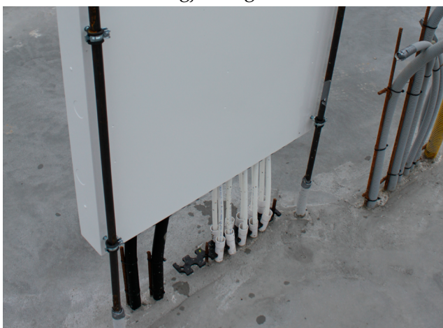
Monterat LK Skåpstativ L2.
