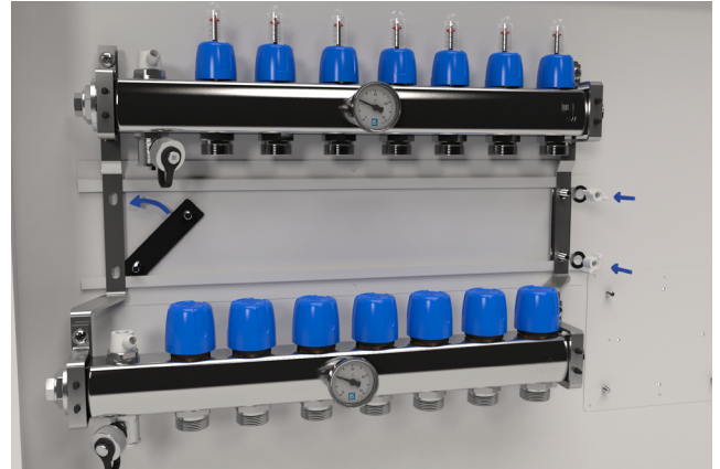
Montage av LK Värmekretsfordelare RF.
