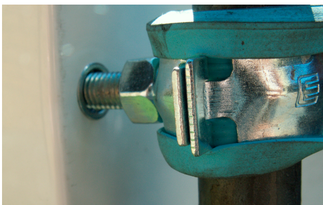
Närbild på infästning mot skåp.
