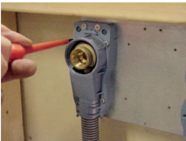
7. Kontrollera att packningen i bakstycket ligger på plats och montera dosans frontstycke med de 4 st medlevererade skruvarna.
