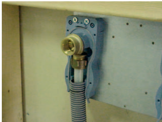
6. Tomrör med PE-X rör och vinkelkoppling fälls in i väggdosans bakstycke.
