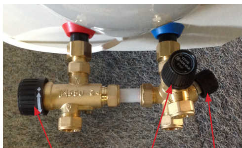
Blandningsventil Säkerhetsventil Ventilrör
