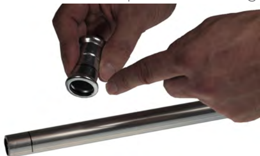
BILD 5: Kontroll av koppling/rör
