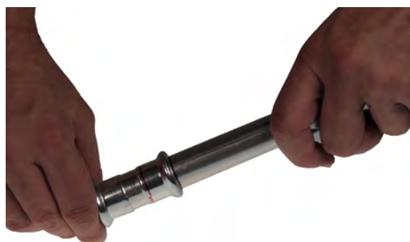
BILD 8: Montera koppling/rör
