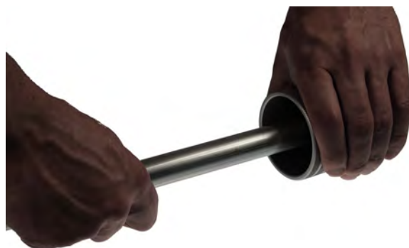
BILD 7: Avgradning av röret
