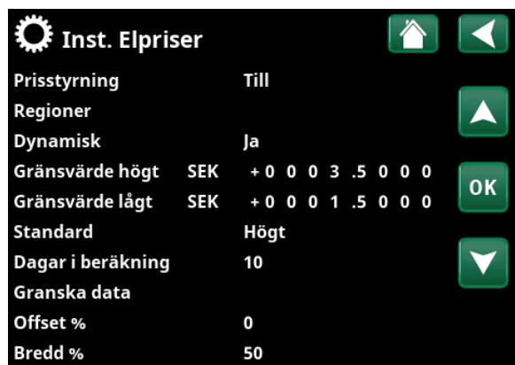
Meny "Avancerat/Inställningar/Kommunikation/Elpriser" vid val "Avancerat/Definiera/Kommunikation/myUplink:Ja".
