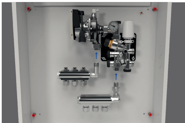
Montage av LK Minifördelare i LK Shuntskåp M60n XL
