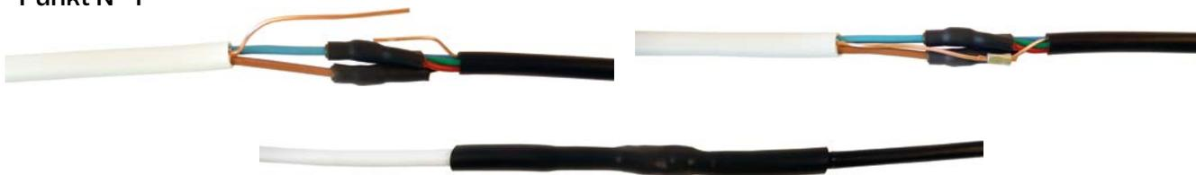
**NB!** Maksimal tillatt avstand mellom innføringsnippel og tillederkobling er 0,5 meter.
