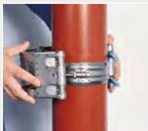
2. Kragen åpnes helt, og legges over rør-sammenføyningen.
