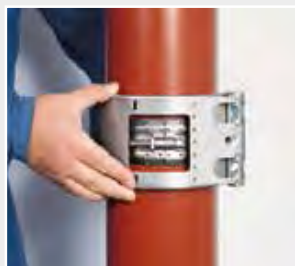
3. Påse at koblingens bolt er fri, og trekk til boltene på kragen.
