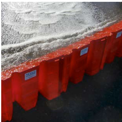
En diagonal boxvall styr bort vattnet
