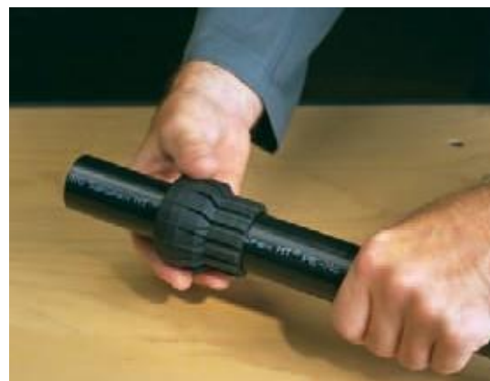
Skjut på kopplingsmuttern på Sanipex MT®-röret.
