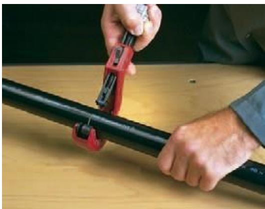
Kapa röret med rörskäraren.
