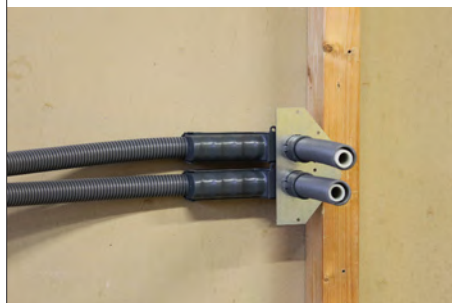
Installationsexempel med LK Fixtur 2 x c/c 40.
