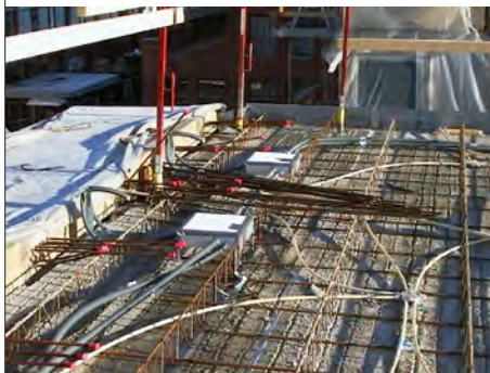
Installationsexempel med LK Kopplingslåda.
