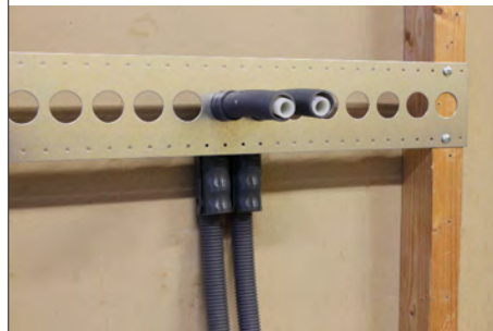
Installationsexempel med LK Väggskena 40.
