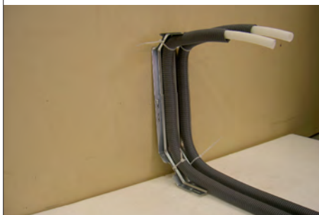
Installationsexempel med LK Bockstöd UNI-Vägg och LK Bockstöd UNI-Golv.
