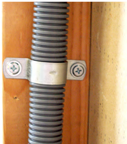
Installationsexempel med LK Klammer, tomrör.
