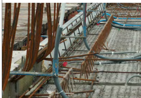
Installationsexempel med LK Rörfixtur UNI c/c 40.
