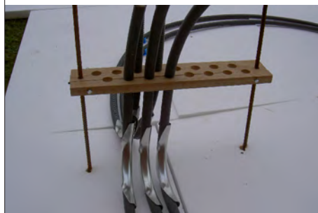
Installationsexempel med LK Fixtur 25-8.
