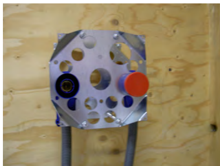
Installationsexempel med LK Montagefixtur betong, monterad på bakre väggform.
