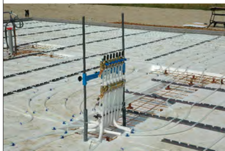
Installationsexempel med LK Fördelarstativ.
