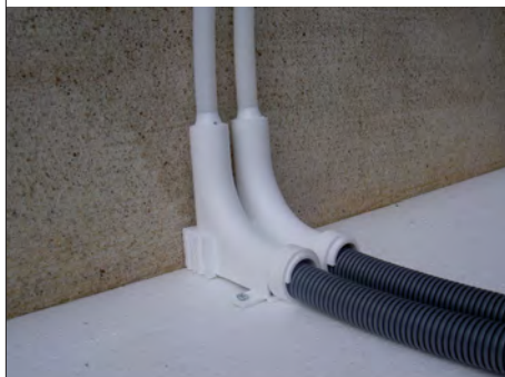
Installationsexempel med LK Radbockstöd.
