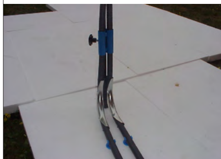
Installationsexempel med LK Rörstolpe.
