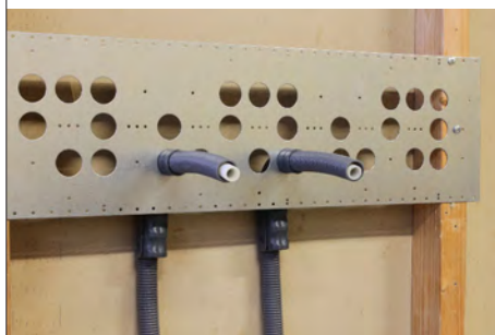
Installationsexempel med LK Väggskena 160.
