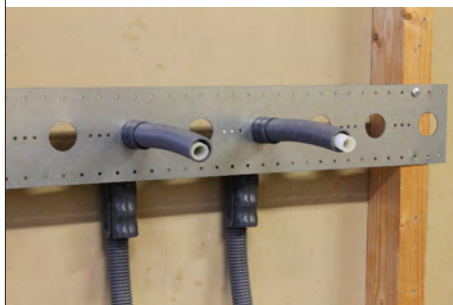
Installationsexempel med LK Väggskena 150.
