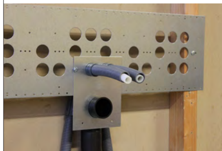
Installationsexempel med LK Avloppsfixtur 2 x 40.
