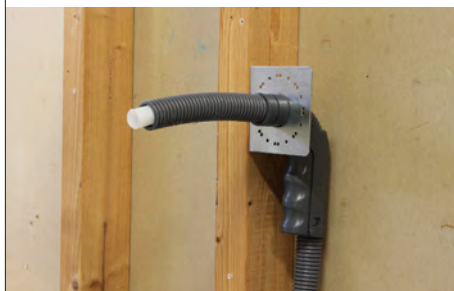
Installationsexempel med LK Väggdosfäste - 1.
