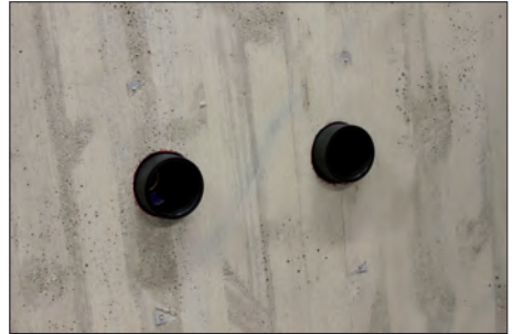
LK Hanakulmarasia UNI 16 ja LK Jatkoholkki UNI asennettuna.
