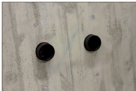
LK Veggbok UNI 16 med LK Forlengeshylse UNI montert.
