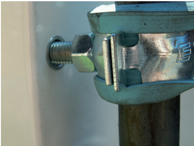
Närbild på infästning mot skåp.
