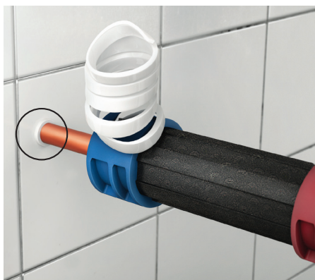
4. Skalverktyget avslutar skalningen automatiskt och lämnar 2 mm av plasten kvar, vilket är kravet i Säker Vatteninstallation.
