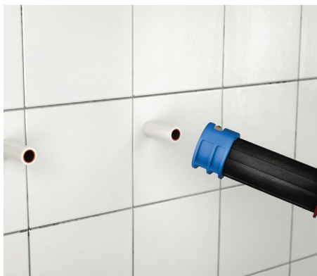
1. För verktyget med rätt dimension mot röret.
