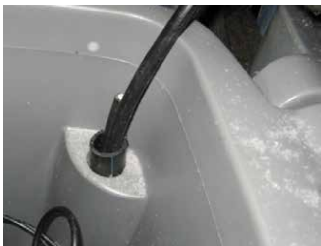
Bild 29. Dra jordkablarna från centralenheten till apparatskåpet, 2 st. (EKK 4x2,5+2,5) och märk bägge ändarna på den ena kablarna med samma märken för att underlätta elmontörens arbete. Förläggning utav kabeln skall ske efter gällande standarder. Jordkabeln skjuts in i apparatskåpet genom monterings-skåran baktill.
