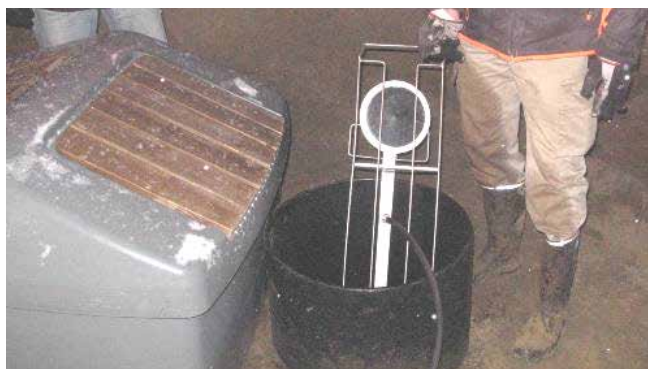
Bild 27. Lyft apparatskåpet bredvid inspektionsbrunnen. I behållarens botten finns luftningsstödet. Tryckluftslangen är fästad i inspektionsbrunnen.
