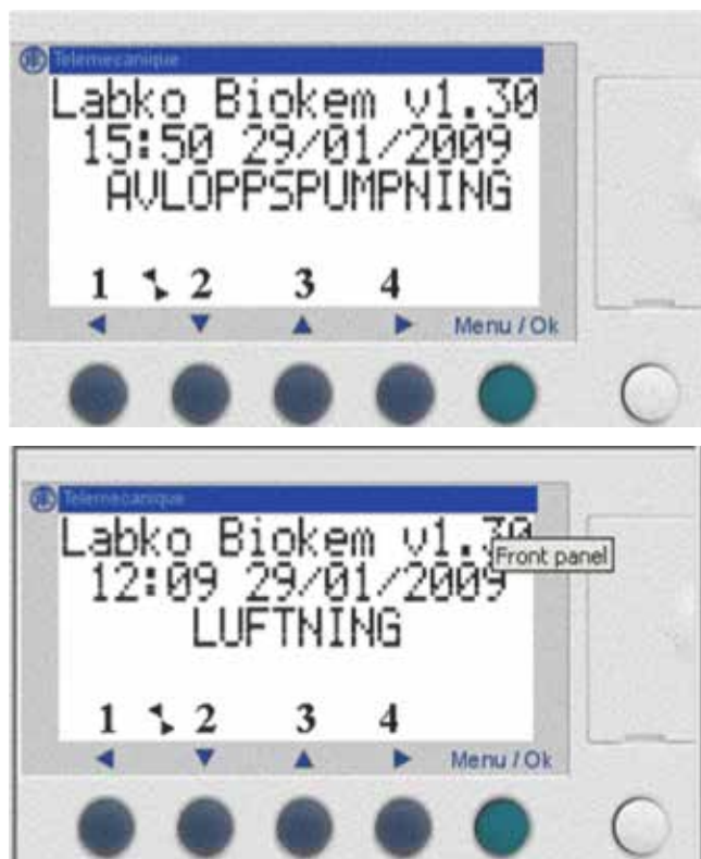
Bild 9. Avloppspumpning och luftning.
