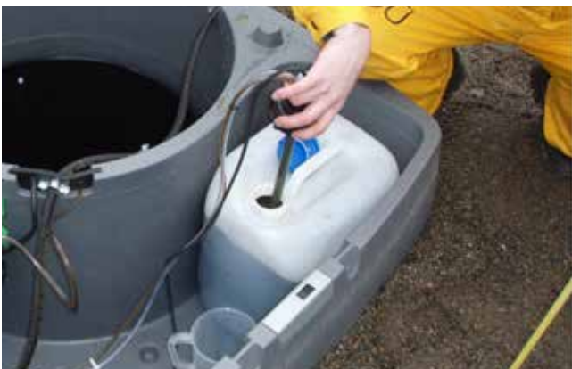
Bild 35. Kemikalieens min.nivåvakt är fabriksinstallerad och kopplad till kopplingsdosan. Ta ut kemikalieens min.nivåvakt ur skyddsförpackningen och lägg den i kemikaliebehållarens öppning. Se till att min.nivåvaktens gröna ytvippa kan röra sig fritt i kemikaliebehållaren. Om ytvippan har fastnat i behållarens vägg ska man korrigerat vippans läge.
