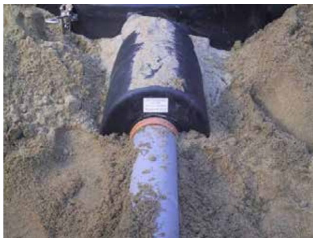
Bild 24. Montera omsorgsfullt det inkommande avloppet inlopps-röret (lutning minst 20 mm/m) och tankens utgående avlopp till utlopps-röret (lutning minst 10 mm/m).
