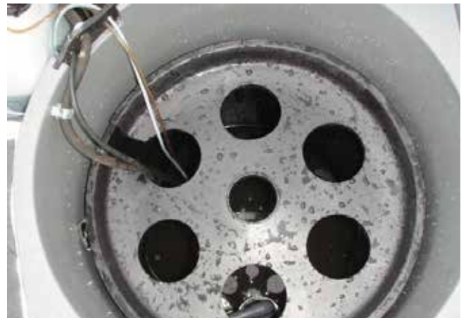
Bild 36. Placera tömningspumpens elledning, luftningsslag och kemikalieslang i processtanken, med säkerhetslocket på plats. (Gäller endast modell BioKem 6 EN). Stäng apparatskåpets låsbara lock.
