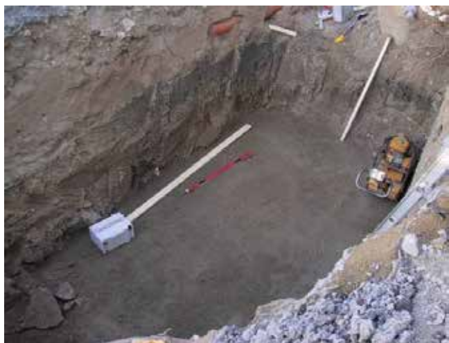
Bild 18. Gräv ett monteringsschakt för tanken. Schaktdjupet varierar enligt det inkommande avloppet. Packa med vibrator ett ca 30 cm tjockt jämnt stenfritt sandskikt på schaktbotten. Använd vatten vid komprimeringen.
