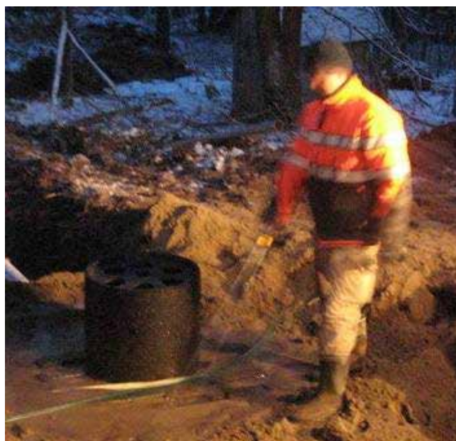
Bild 25. Fortsätt att fylla på sand tills det är ett ca 30 cm tjockt, packat sandskikt mellan inspektionsbrunnen och processtan-kens överkant. Komprimera marken med hjälp av vatten. Det är absolut förbjudet att använda vibrator ovanpå tanken!
