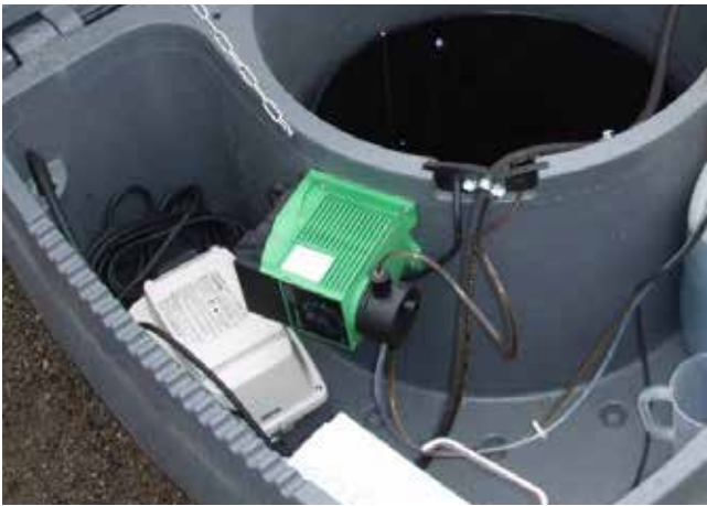
Bild 33. Inspektionsbrunnens genomföringstättning För tömningspumpens elledning och luftningsslangen genom inspektionsbrunnens genomföringstättning. Luftningsslangen installeras i kompressorns tryckluftsanslutning med en gummifog och dras åt med två spännrullar. Kemikaliepumpens tryckslang är färdiginstallerad i processtanken.
