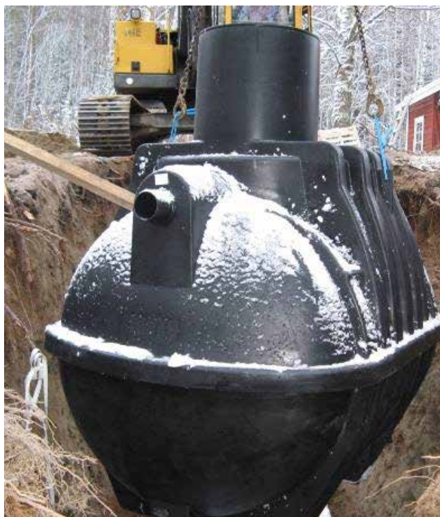
Lyft processtanken i lyftöglorna ner i schaktet.
