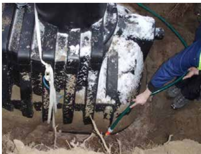
Bild 23. Fortsätt att fylla på sand i 20–30 cm skikt. Packa sandskikten ordentligt med hjälp av vatten och vibrator. Använd ovillkorligen stenfri sand, eftersom stenarna kan pressa sönder tanken under komprimeringen eller om våren när tjälen smälter.
