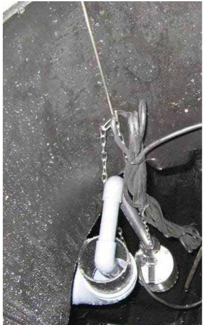
Bild16a+b. Installering av tömningspumpen i inspektionsbrunnen.
