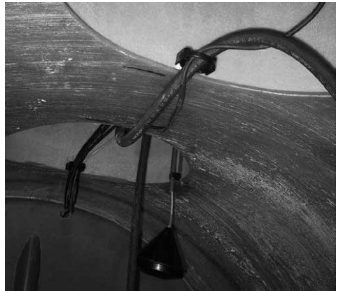
Bild 18. Infästning av kablar och tryckluftslangar inne i -processtanken.
