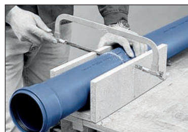
Kapning med fintandad såg (FIGUR 20)
