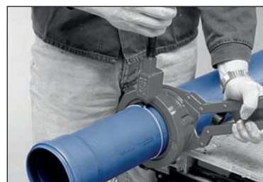
Kapning med kapnings- och fasningsapparat (FIGUR 19)
