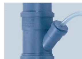
Montera in kondensutlopp i ledningen. (FIGUR 40)
