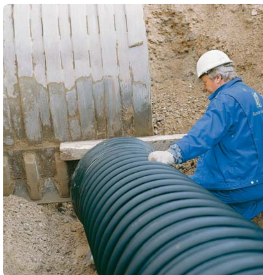
4. Vid montering används spett, hopdragningsverktyg eller grävmaskin. Glöm inte att skydda röret/rördelen med en plank eller liknande.
