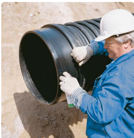
3. Stryk smörjmedel på rörets spetsända.
