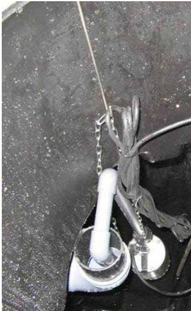
Bild16a+b. Installering av tömningspumpen i inspektionsbrunnen.
