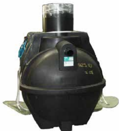
Bild 21. Placera förankringslinorna över tanken, dra förankringslinorna genom hålen i plattorna och knyt fast linorna med minst dubbla knutar. Börja fylla schaktet med sand. Kontrollera att linorna är spända.
