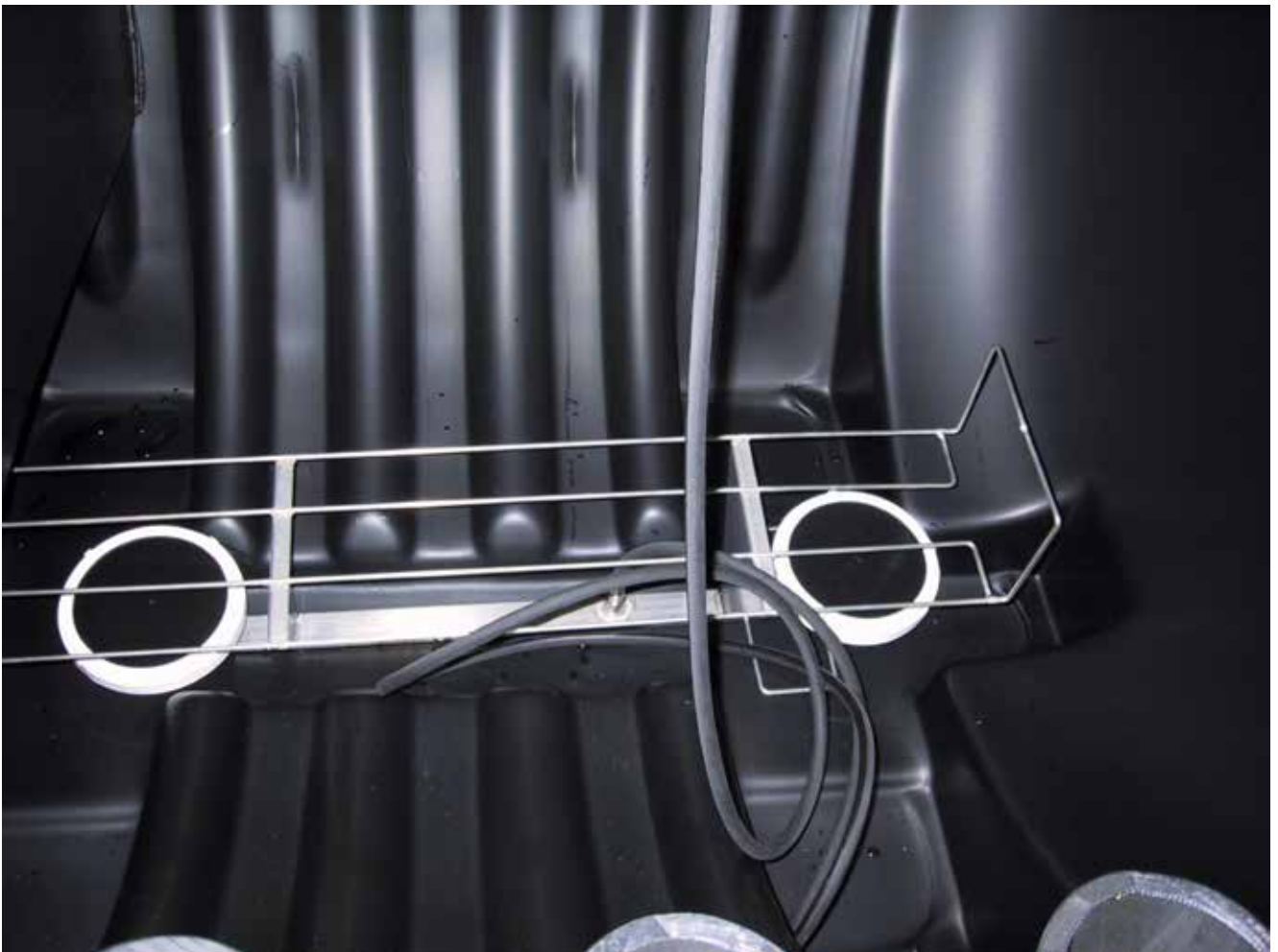
Bild 15. Åt detta håll ska luftningsdysorna placeras inuti tanken.
