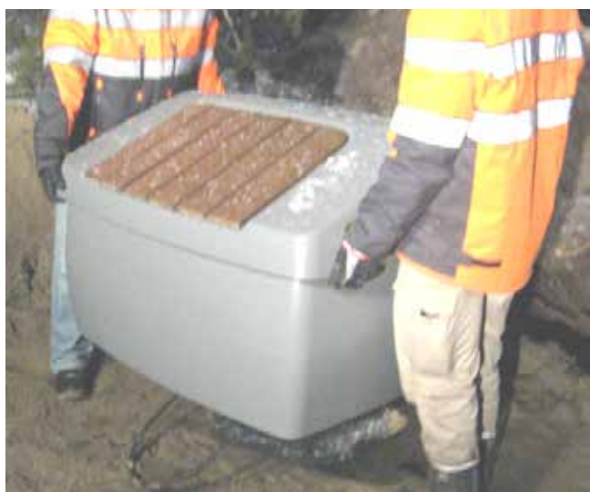
Bild 28. Lyft apparatskåpet ovanpå inspektionsbrunnen i önskad ställning när rätt markhöjd uppnåtts.
