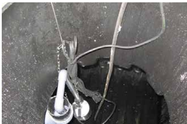
Bild 32. Häng upp tömningspumpen i det utgående avloppet D110 i en kedja. Kedjan fästs med upphängningskrok i inspektionsbrunnens övre kant (Bild 15). Tömningspumpen får inte hänga i D32 tömningsröret eller elledningen, endast i kedjan.
