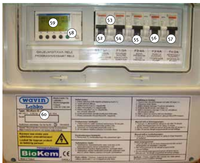
Bild 4. Centralenheten 52. Huvudströmbrytare 53. Felströmsskydd 54. Styr säkring 55. Kompressorsäkring 56. Tömningspumpens säkring 57. Kemikaliepumpens säkring 58. Zelio-relä 59. LCD-display 60. Kväveplåt
