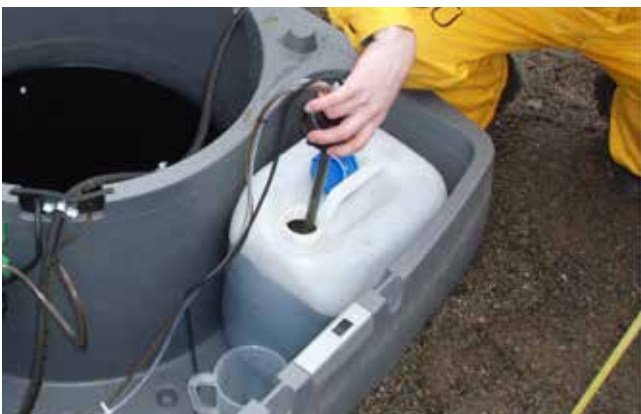
Bild 35. Kemikalieens min.nivåvakt är fabriksinstallerad och kopplad till kopplingsdosan. Ta ut kemikalieens min.nivåvakt ur skyddsförpackningen och lägg den i kemikaliebehållarens öppning. Se till att min.nivåvaktens gröna ytvippa kan röra sig fritt i kemikaliebehållaren. Om ytvippan har fastnat i behållarens vägg ska man korrigera vippans läge.
