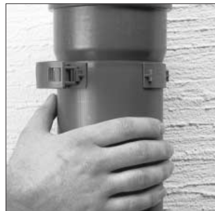
(BILD 52) Montage av rör med POLO-CLIP klamma
