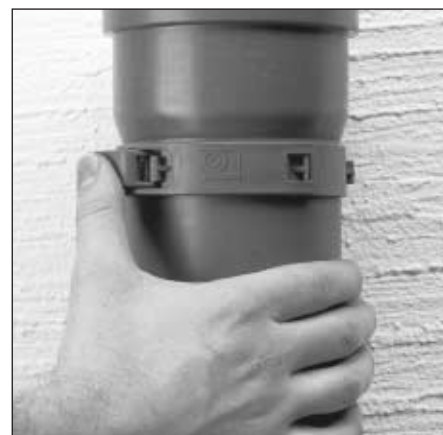
(BILD 53) Låsning av spänne
