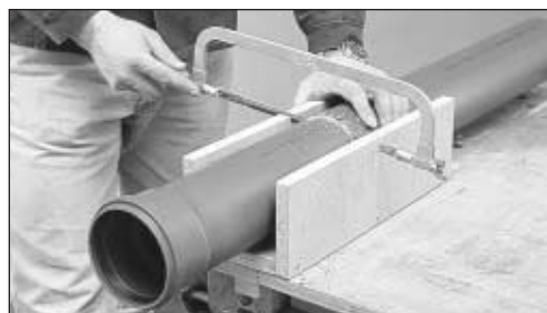
(BILD 16) Kapning med fintandad såg
