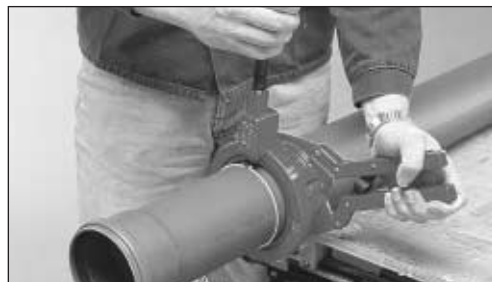
(BILD 15) Kapning med kap- och fasverktyg
