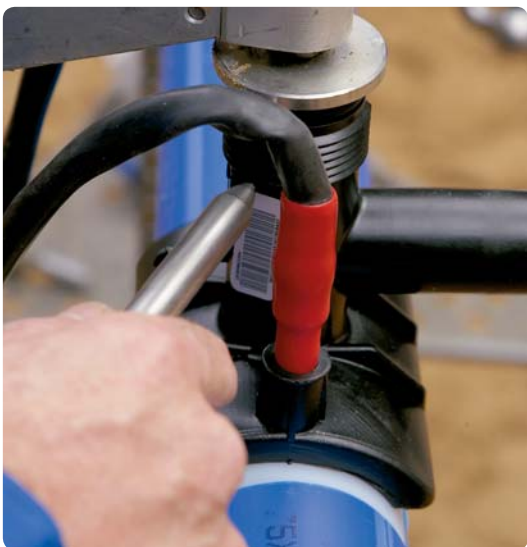
7. Därefter utförs elektrosvetsning.
