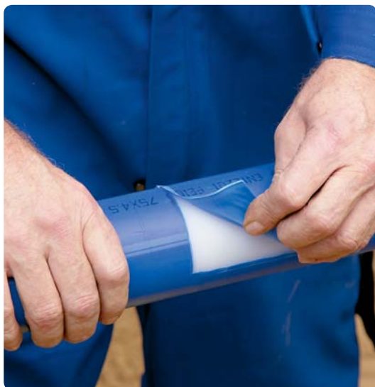
3. Avlägsna det markerade PP-mantelstycket omedelbart före svetsning.
