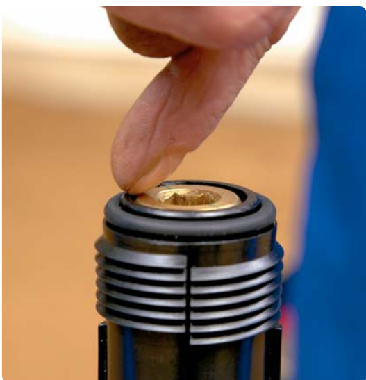
9. När anborrningskruven skruvas ur, är det viktigt att den inte skruvas för långt upp, eftersom det ska finnas plats för att skruva på skyddshatten, så att den sluter tätt.
