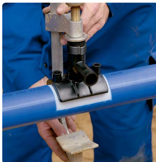
5. Fäst rördelen på Profuse-röret med hållverktyget.
