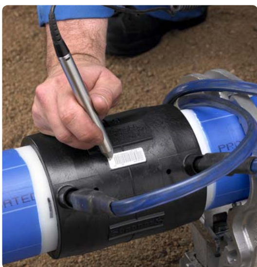
7. Avläs svetsdata med hjälp av streckkodssystemet.
