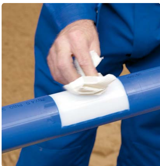
4. Röret torkas av med rengöringsvätska före svetsning.
