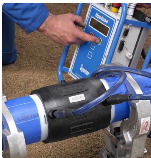
8. Därefter utförs elektrosvetsning.
