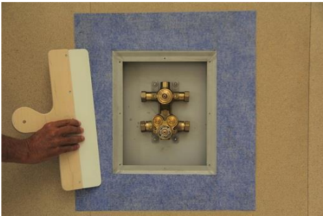
4- Stryk ut manschette nogga och säkerställ så att inga veck eller luftblåsor uppstår.
