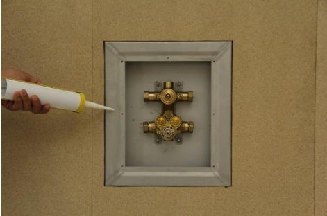
2 - Applicera ARDEX SK 105 MS på skåpets fläns. Stryk ut med fintandad limspredare.
