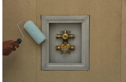
3 - Applicera ARDEX 7x8 på övriga väggytan som manchetten skall täcka.
