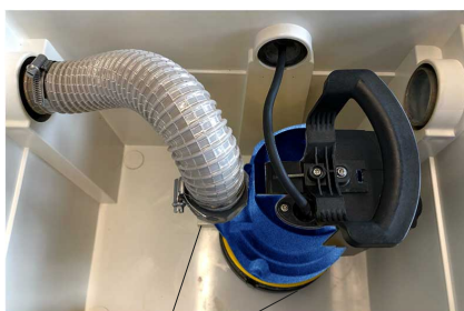
Bild 16: Montera Ama-Drainer 301/Ama-Drainer 301 C
