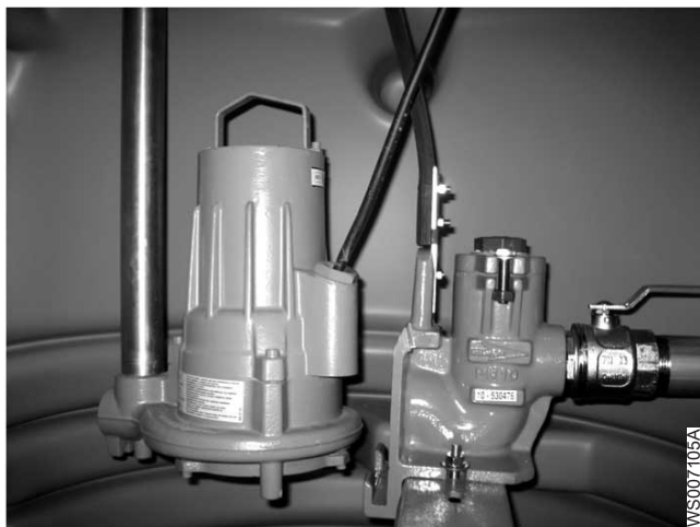
d) Stoppa nedsänkningen när glidskon kommer i ingrepp med tryckanslutningen med backventilen.
