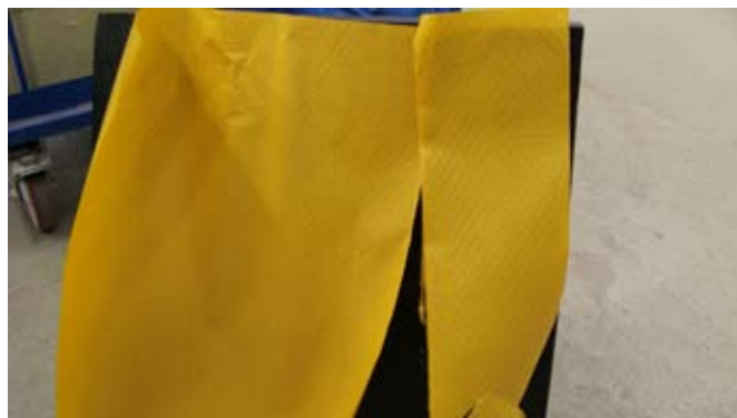
2. Ta bort skyddspapp på isolering
