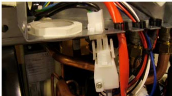
C. Montage av kompressorkablage.
