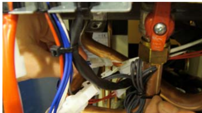
D. Montering av 2-poligt givarkablage.
