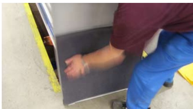
5. Tryck till så att isoleringen fastnar
