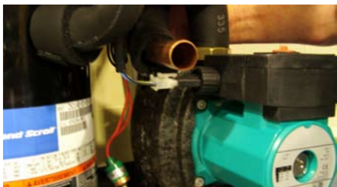
A. Montering av 3-poligt don i KB-pump
