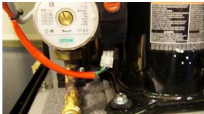
B. Montering av 3-poligt don i VP-pump
