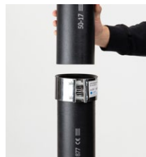
Skjut in den andra rörändan i gummi-manschetten.
