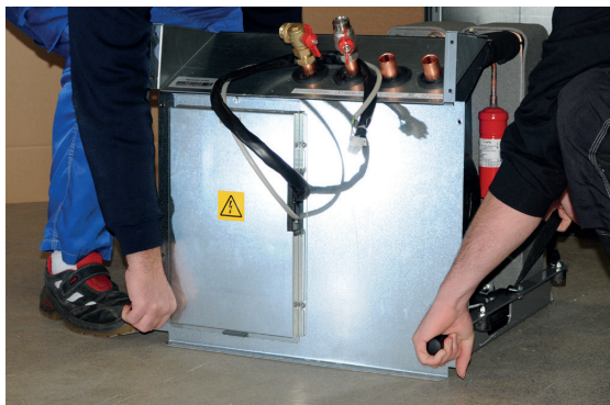
5. Lyft kylmodulen med hjälp av bärhandtag och bärremmar.
