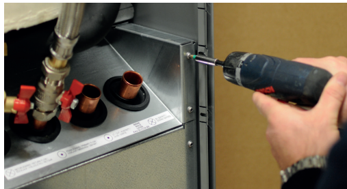
3. Avlägsna kylmodulens fästskruvar.
