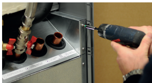
3. Avlägsna kylmodulens fästsruvar.
