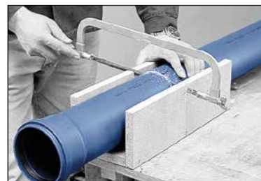
Kapning med fintandad såg (FIGUR 17)
