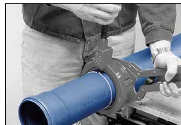
Kapning med kapnings- och fasningsapparat (FIGUR 16)
