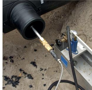
Führen Sie die Dichtheitsprüfung durch.
