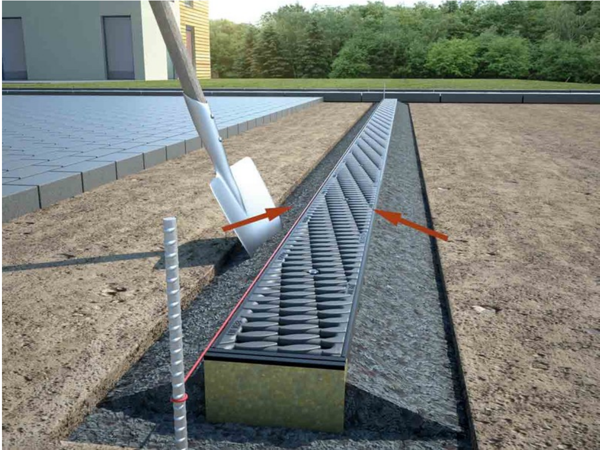
6. Motgjut med betong mot rännkroppens sida.
