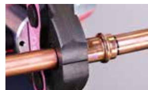
12. Tryck på beslaget med det godkända pressverktyget
