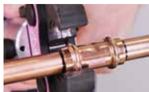
11. Styr monteringen i pressklon
