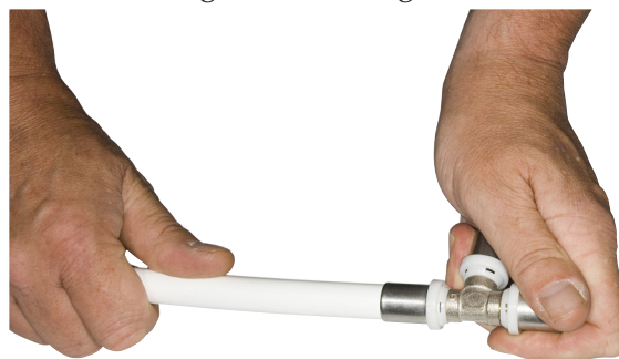
Inskjutning och vridning av det gradade röret.
