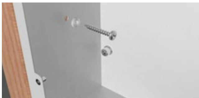
Infästning av skåp i regelvägg.
