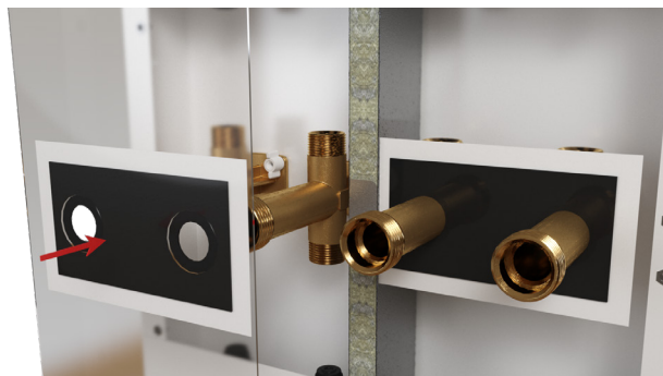
Montage av sprutskydd
