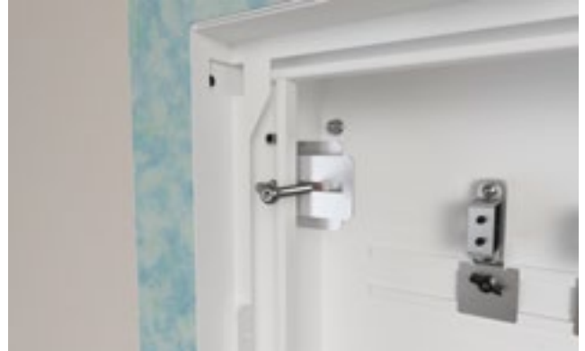
Våtzensluckan monteras i skåpet.
