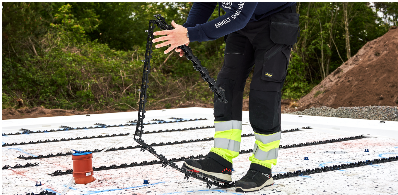
VVS-montören vecklar ut och lägger ner listen på EPS-isoleringen.
