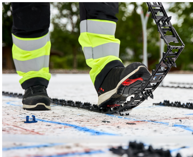
LK Golvvärmelist Combi 16/20 på EPS-isolering.
