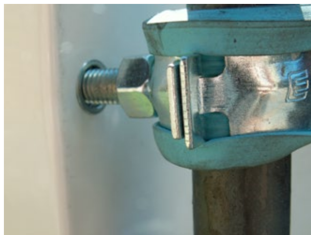
Närbild på infästning mot skåp.
