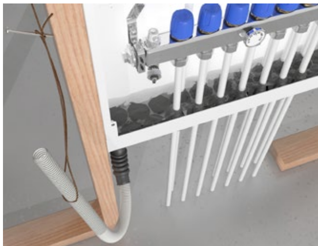
Täthetskontroll av skåpsbotten
