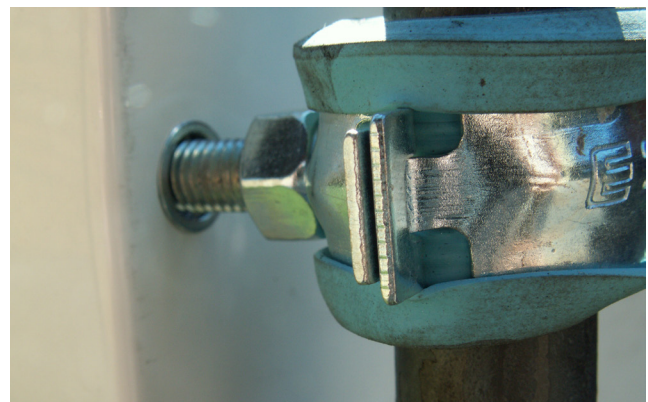
Närbild på infästning mot skåp.
