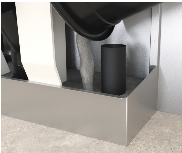
Schaktbotten och eventuell håltagning gjuts igen.
