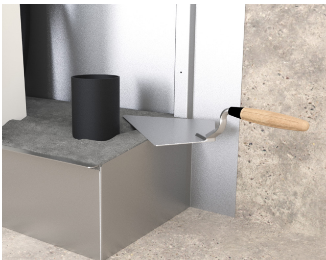
Schaktbotten formas med fall.
