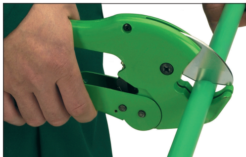
Avklippning av röret
