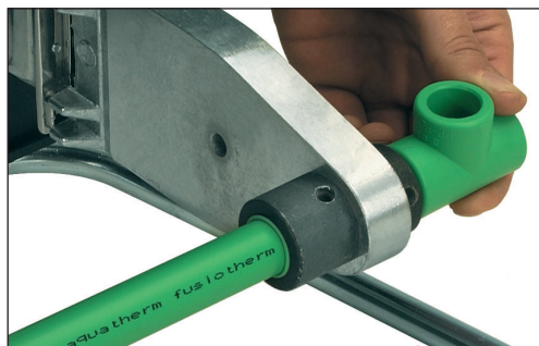
Upphettning av rör och rördel
