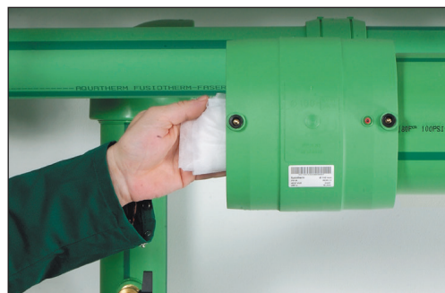
Rengör elektrossvetsmuffen igen med rengöringsduken
