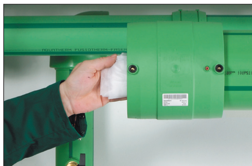
Rengör elektrossvetsmuffen igen med rengöringsduken
