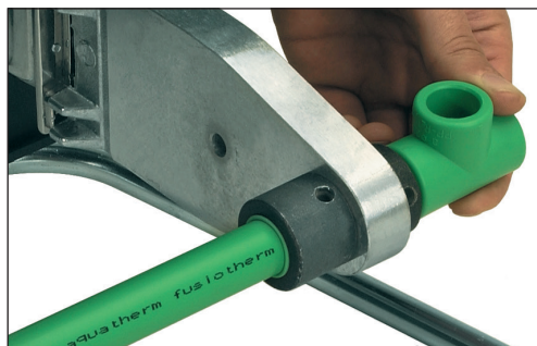
Upphettning av rör och rördel
