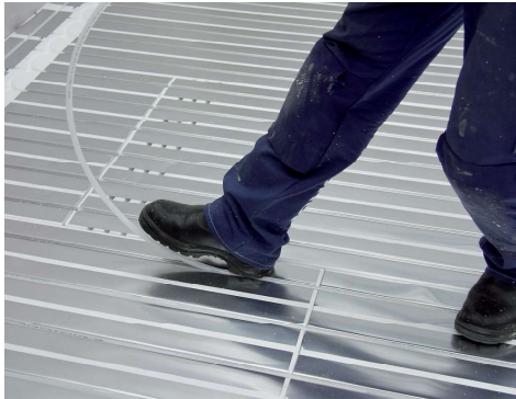
11. Rördragning i rakt spår.
