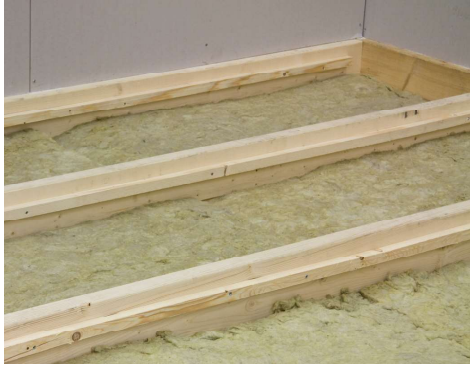
3. Bjälkar med monterad bärläkt.
