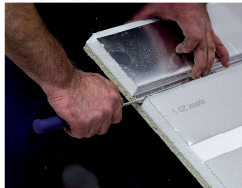
6. Avgrada plåtarna där röret ska ligga.
