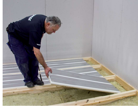
4. Lägg kassetterna cirka 30 cm från väggen för att få plats för rörets vändningar. Kassetterna ska ligga med minst 10 mm och max 100 mm mellanrum.
