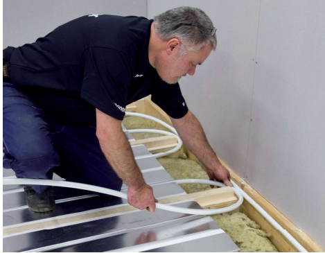
11. Vändöglorna kan hållas på plats med ett skrubband.
