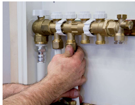
14. Skruva fast kopplingen i fördelaren.
