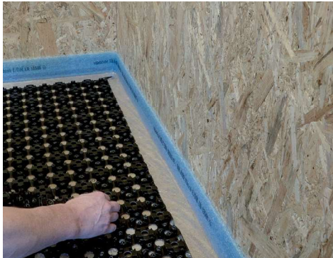
9. Börja rad 2 med biten som blev över på rad 1 fäst den i ovanliggande skiva.
