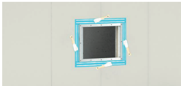
2. Sprid ut limmet med fintandad limsridare / Spackelspade.
