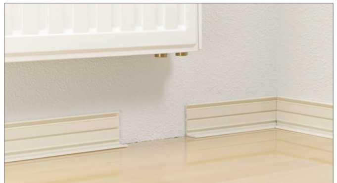
Fig. 16-21 Installerad RAUSOLO sockelkanalunderdel med utskärning
