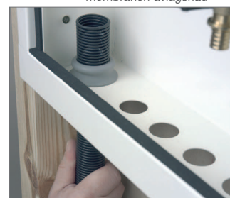
Fig. 5-17 Dra tillbaka skyddsror 1 cm för att åstadkomma tätning
