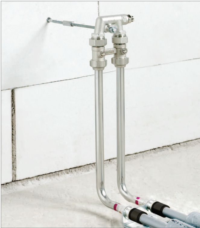
Fig. 15-9 Radiatorbygel - installationsexemplar
