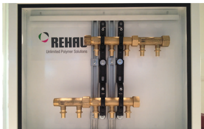
Fig. 5-13 Installation av fördelare
