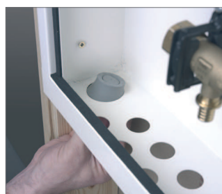
Fig. 5-14 Sätt in gummitätning 28-34
