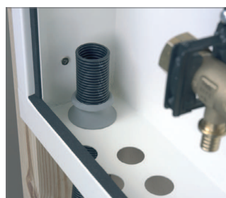
Fig. 5-16 Sätt in skyddsror - min. 6 cm
