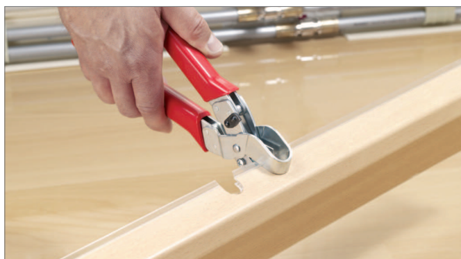
Fig. 16-25 Stansa ut sockelkanalens överdel
