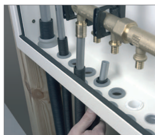
Fig. 5-18 Skjut in skyddsror 25 - minst 1 cm över tätning
