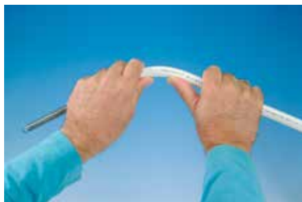
Böjning med invändig fjäder
